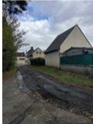
Lors des travaux Rue Hotin
