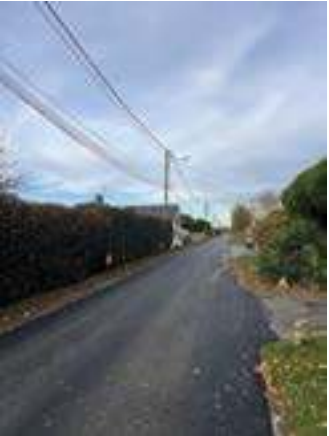
Rue de la Garenne, Villotran avec aménagement des entrées charretières
