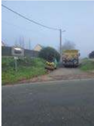
Lors des travaux Chemin de Berneuil
