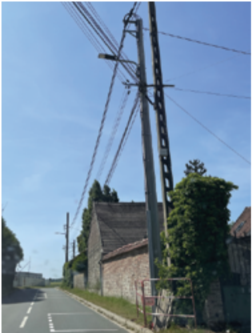
Des travaux de remplacements de poteaux électriques effectués par le Syndicat d'Electrification de l'Oise à Malassise et Chemin des Longues Mines.
