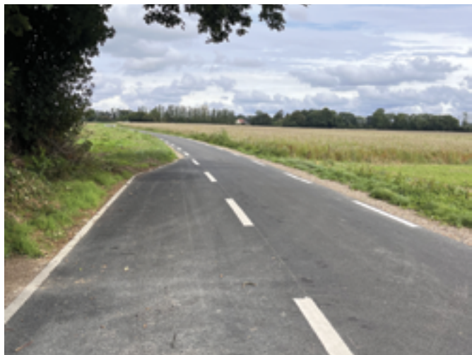
Rénovation de la voirie entre La Neuville Garnier et Beaumont les Nonains
