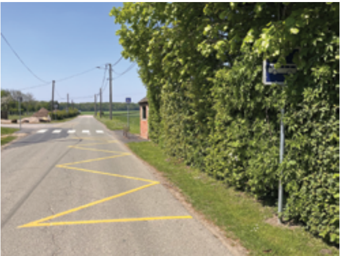
Mise aux normes des arrêts de cars de la commune
