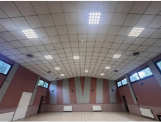
Salle des fêtes de Villotran Remplacement de l'ancien éclairage par des leds
