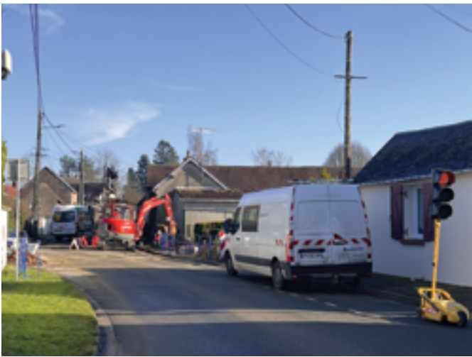
Mare rue du Point du Jour Les deux traversées de route en eaux pluviales ont été refaites par la Communauté de Communes des Sablons au mois de février 2025.
