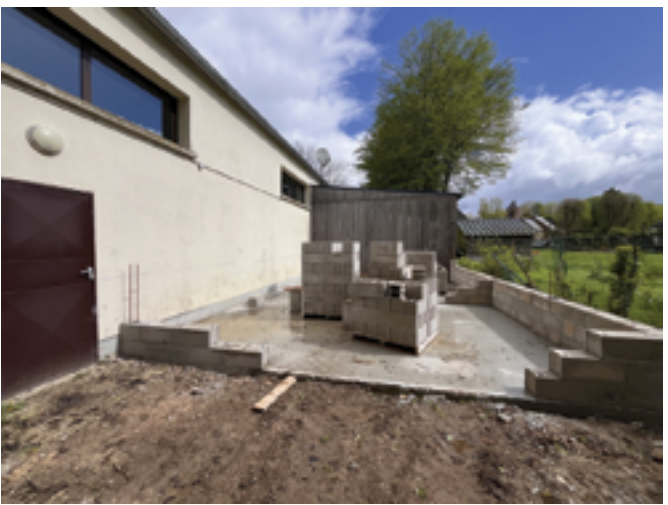
Extention du local de rangement dans la salle des fêtes de Villotran
