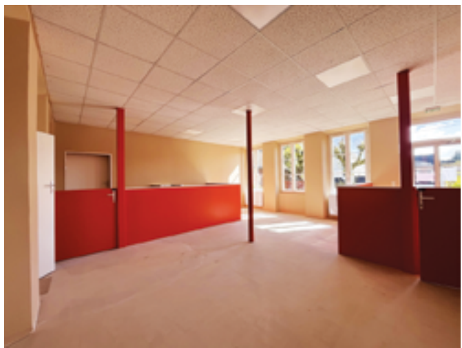
Maison des Assistantes Maternelles Les travaux se poursuivent à la MAM située à la Neuville-Garnier. L'ouverture est prévue en septembre 2024. Le sol a été réalisé au printemps, puis viendra l'aménagement avec l'installation des électroménagers, du coin sanitaire composé d'une table à langer ainsi que d'un WC et lavabo adaptés aux enfants.
