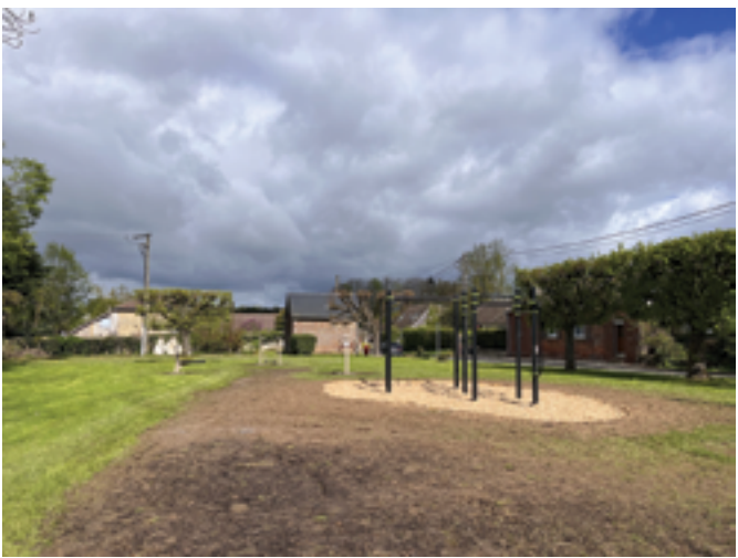
Installation d'équipements sportifs extérieurs à la Neuville-Garnier et à Villotran ( un au niveau de la mairie et un autre au niveau du Verger ) Subventionnés totalement par la Communauté de communes des Sablons
